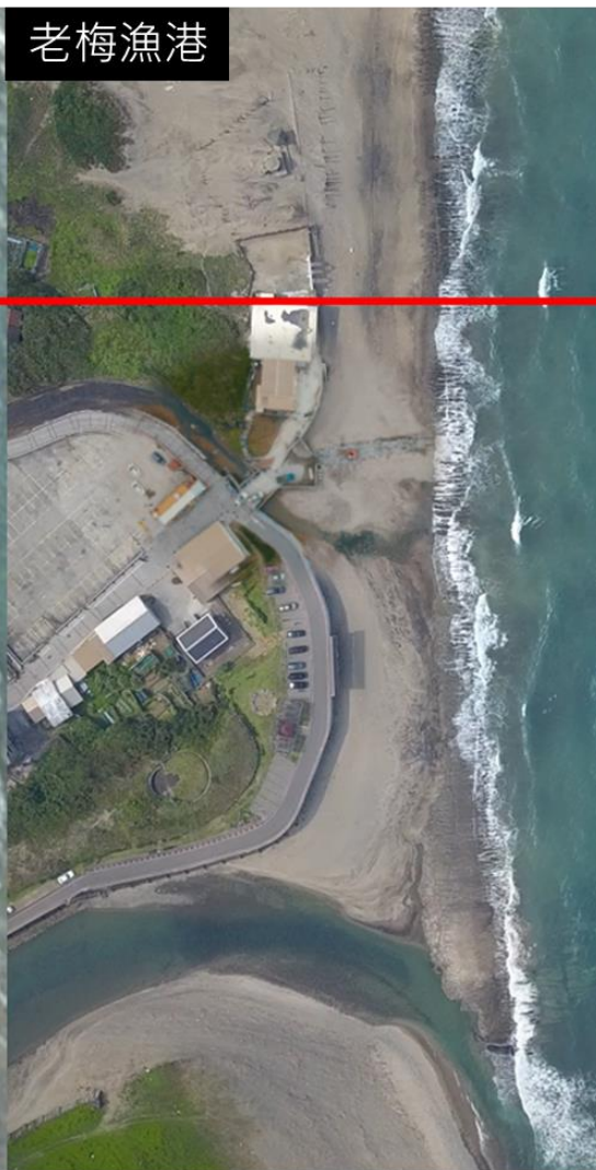
漁港拆除施工中 (民國107年4月17日)
