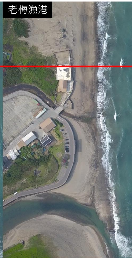
漁港拆除完工後 (民國108年1月28日)
